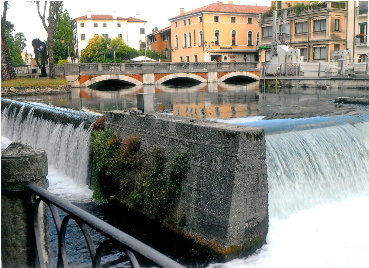
Kleinkraftwerk an der Sile in Treviso (1,73 MW bei 2,5 bis 3 m Fallhöhe) – ein technisches Kunstwerk
